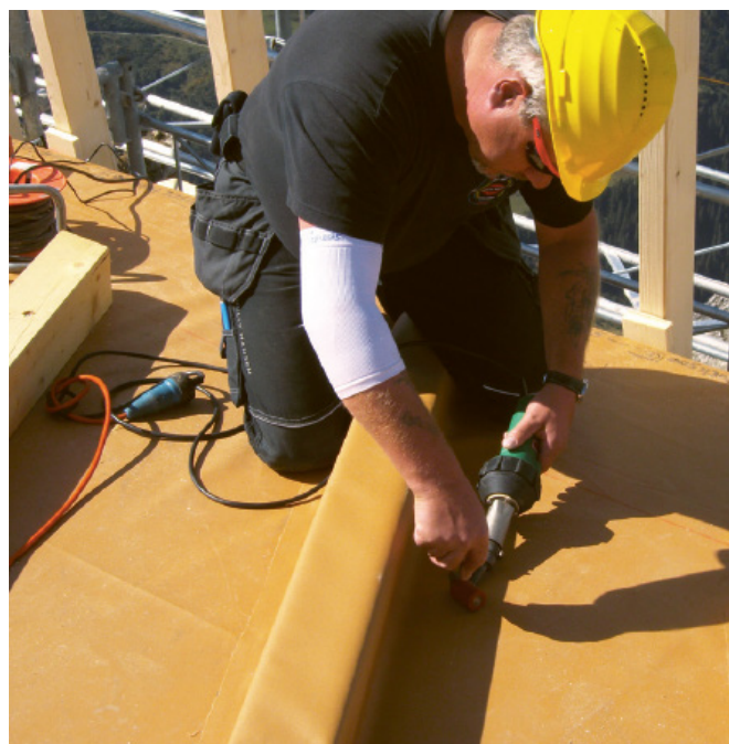
Fig. 3: Soudage complet de la contre-latte.
